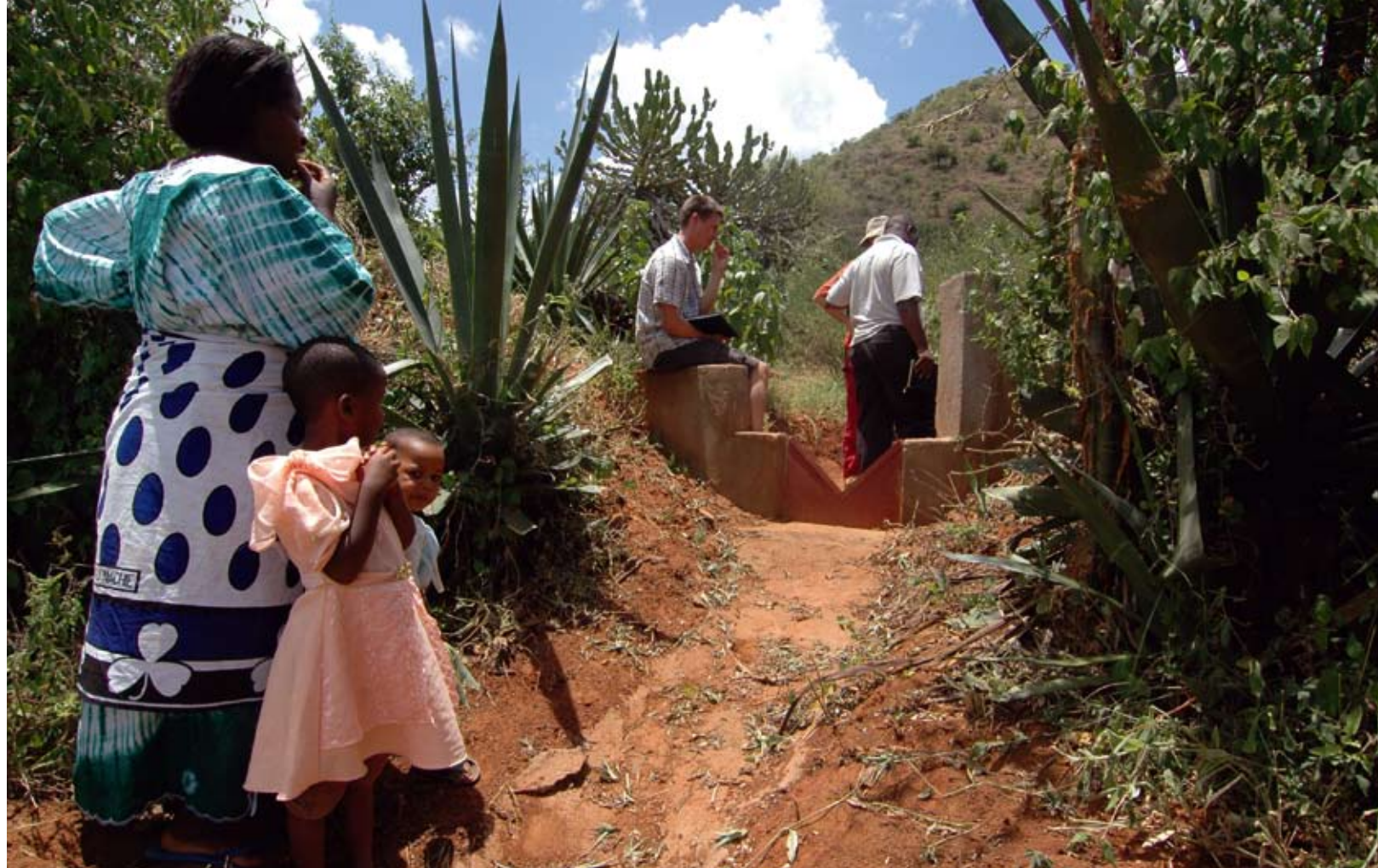
Inspectie van een klein inlaatwerk, waarmee de boer tijdens een regenbui oppervlakkige afvoer naar de greppels kan leiden. De boerin kijkt toe.
